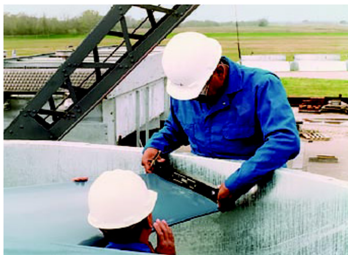
FIG. 1 Il est important de savoir où prendre la lecture du pas.
